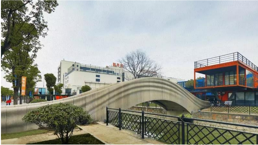
图 3-48 位于上海宝山智慧湾科创园的 3D 打印混凝土步行桥
