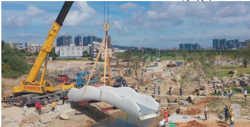
图 3-47 位于福建泉州百崎湖生态连绵带的 3D 打印景观桥
