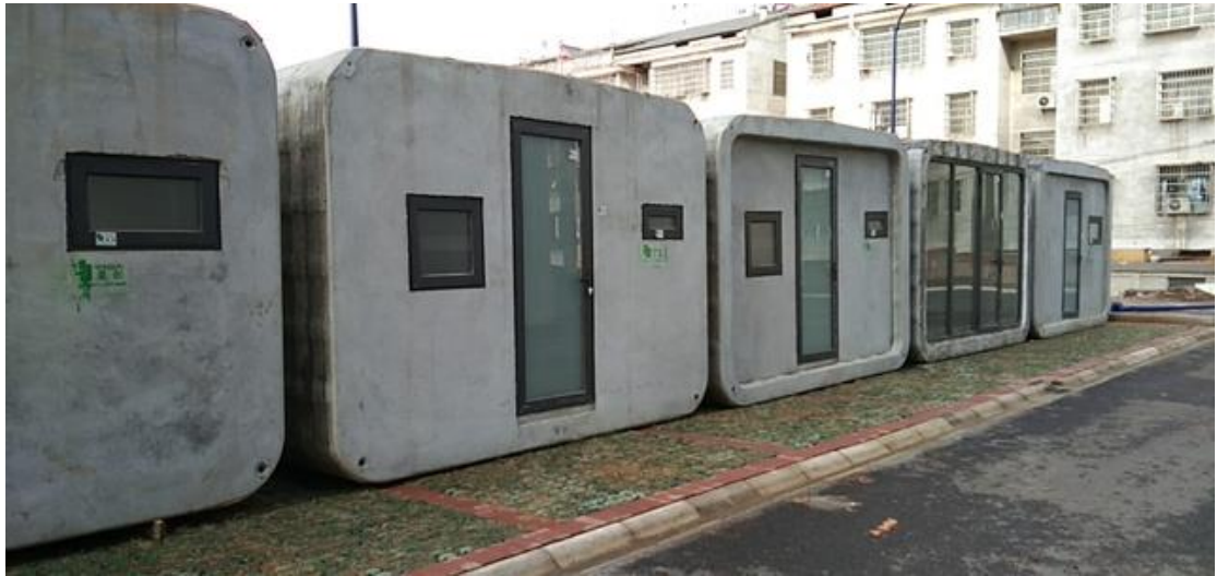
图 3-49 位于湖北咸宁市中心医院的混凝土 3D 打印隔离屋
