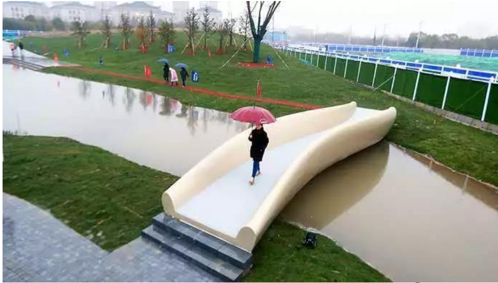
图 3-46 位于上海普陀桃浦中央绿地的 3D 打印景观桥
