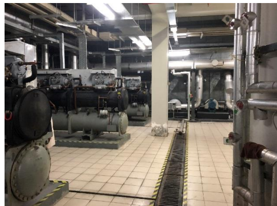
B 座螺杆式冷水机组
