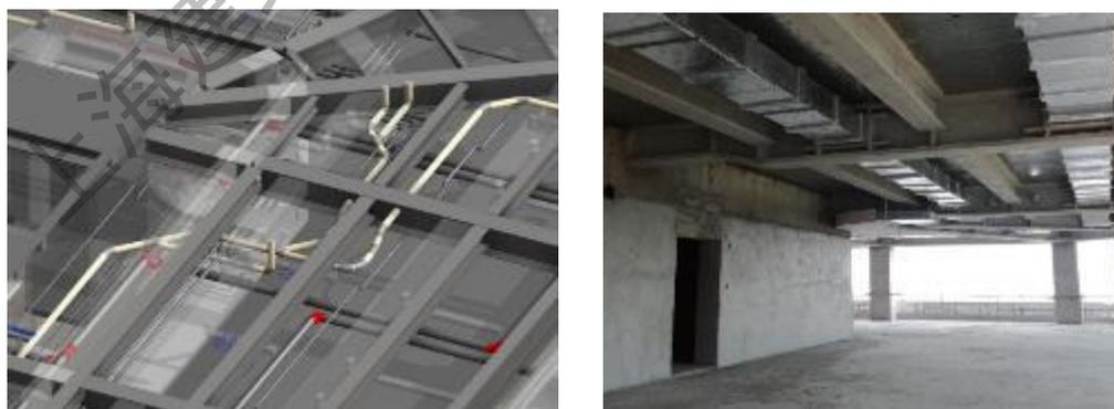
图 13 1号楼标准层管道穿钢梁优化效果图及现场实景
