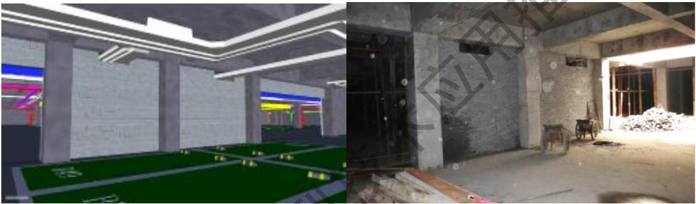
图 23 BIM 模型与现场对比图
