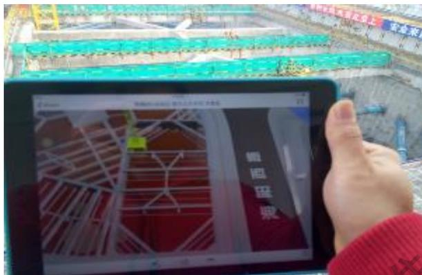
图 12 基于移动端的现场施工指导
