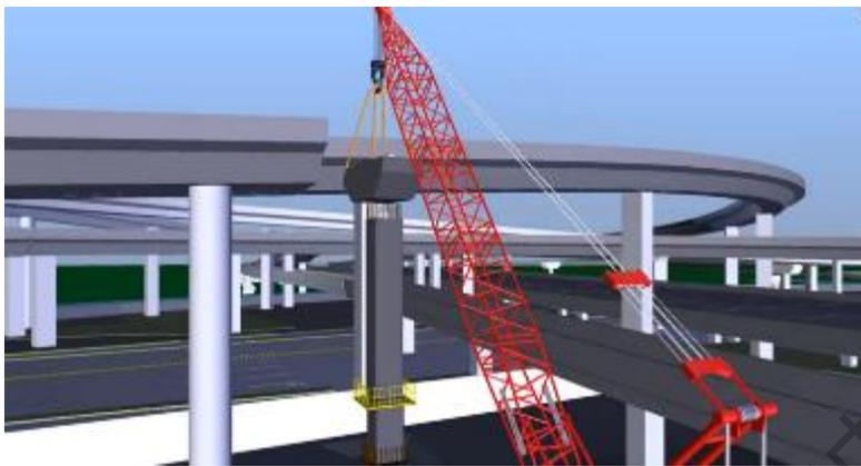
图 41 预制构件安装模拟
