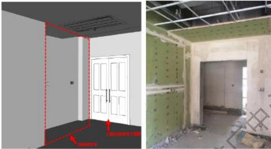
图 39 某实验室的风井隔墙被拉齐
