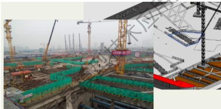
图 7 模拟塔吊施工风险评估
