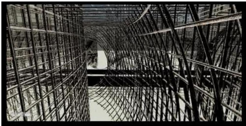
图 13 张马泵站流道处的钢筋布置
