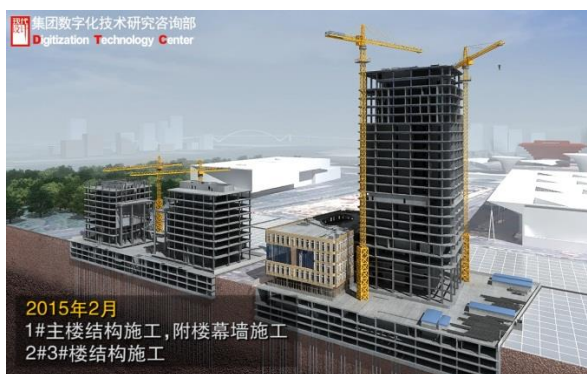
图9 BIM 施工方案模拟示意图
