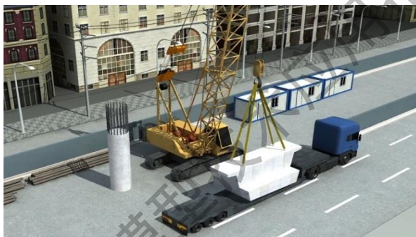
图 15 盖梁现场运输模拟
